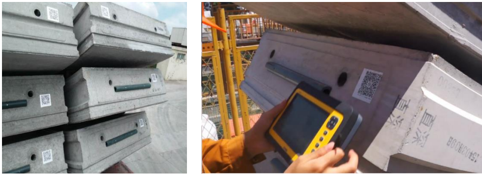
图7-38 现场二维码应用情况
