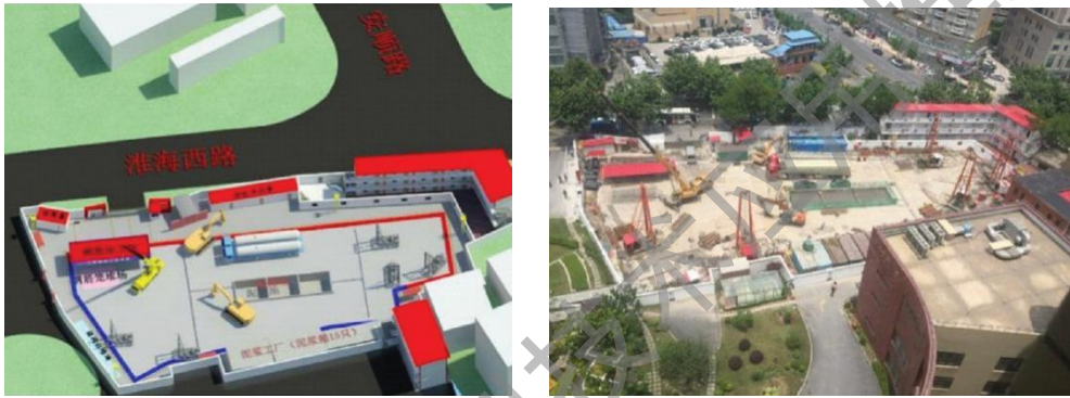
图3-9施工场地BIM模拟及现场施工实景
