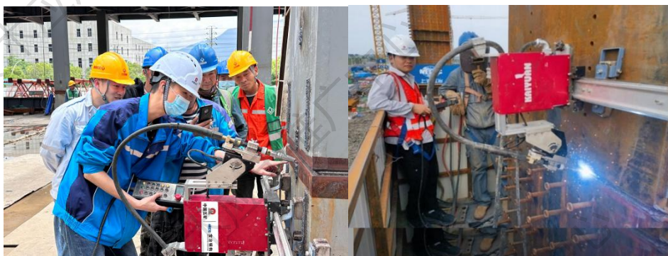
图 3.1.6-8 便携式焊接机器人应用场景
