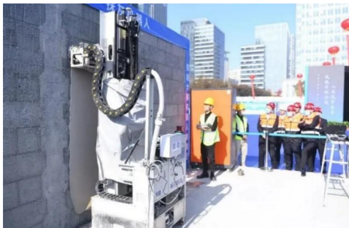
图3.3.4-2 抹灰机器人作业展示
