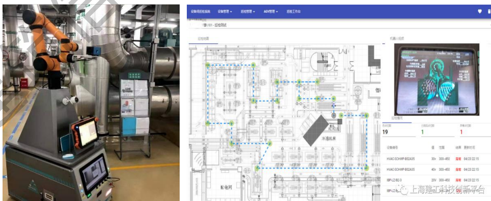
图3.3.4-5 智能巡检机器人
