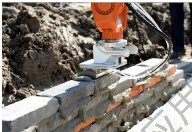
图3.3.4-7 中共一大纪念馆砌墙机器人的应用
