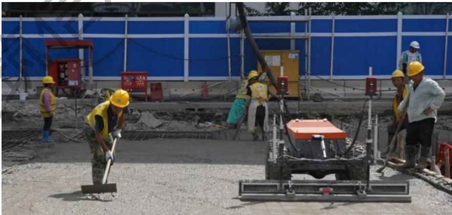
图3.3.4-6 混凝土处理机器人现场作业
