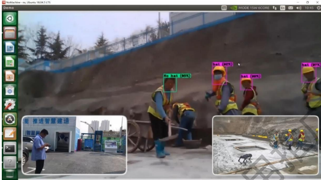
图 3.3.1-5 四足机器人实时捕捉现场视频
