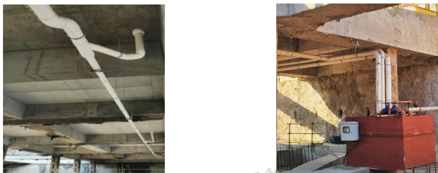
图 5.9 超大基坑绿色排水集水技术
