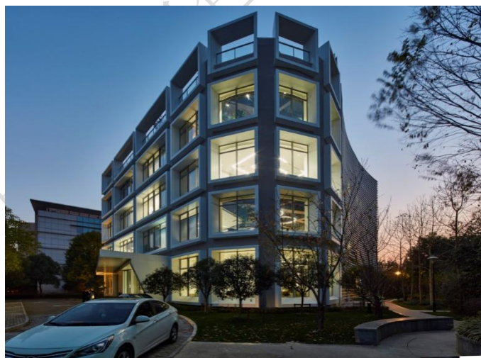
图 5.24 上海朗诗绿色中心改造项目实景
