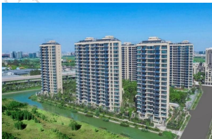
图 5.16 三湘海尚福邸项目实景
