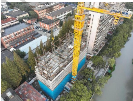
图 5.7 项目钢结构体系建造
