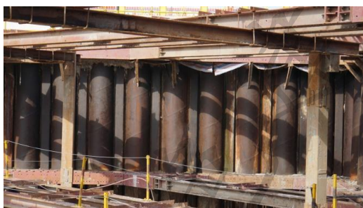
图 5.19 PC 工法组合钢管桩围护
